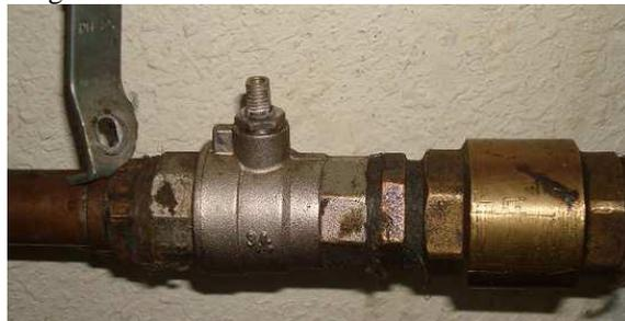
Este dispositivo que, por lo general, será manual, estará compuesto por una válvula de corte y una válvula antirretorno, que impedirán fugas del circuito de calefacción hacia la red de agua fría si esta posee menor presión. Su conexión a la instalación se realizará, a poder ser, en el retorno, para evitar choques térmicos si el llenado se produce con la instalación en funcionamiento.
