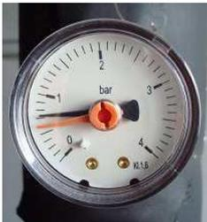
Al igual que para el vaso de expansión, la presión de llenado en el circuito dependerá de la altura manométrica de la instalación y siempre será mayor que esta, con el fin de impedir la entrada de aire del exterior y de facilitar la purga del mismo.
