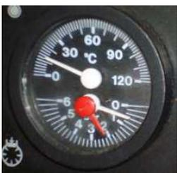
Para nosotros, el sistema de calefacción será un circuito en el que calentaremos agua y, dependiendo de la temperatura de esta, los locales calefactados dispondrán o no de la temperatura requerida. Por eso es imprescindible la existencia de un termómetro que mida en todo instante la temperatura del agua.
