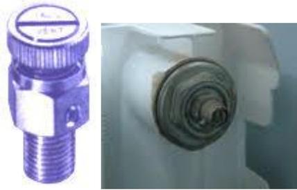
Un enlace detentor que se instalará a la salida de cada emisor y que juntamente con la llave de reglaje, permitirá desmontar el emisor sin necesidad de vaciar el agua de la instalación. La regulación se puede hacer también el detentor, a pesar de que éstos están totalmente cerrados o abiertos o en posiciones intermedias determinadas. Al necesitar una herramienta específica para regularlo, no lo hacen los usuarios.
