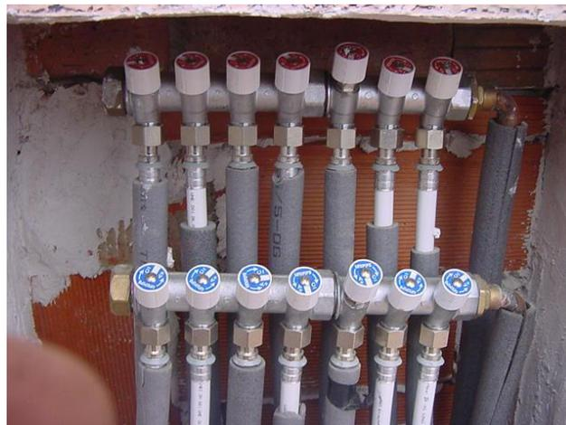
Sistemas Mixtos : Son una combinación de un sistema bitubular con otro monotubular. Normalmente resuelven mediante un sistema bitubular los tramos principales, entregando un sistema monotubular para los secundarios.
