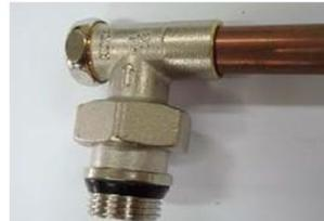
D: Detentor unido al tubo mediante soldadura heterogénea.
