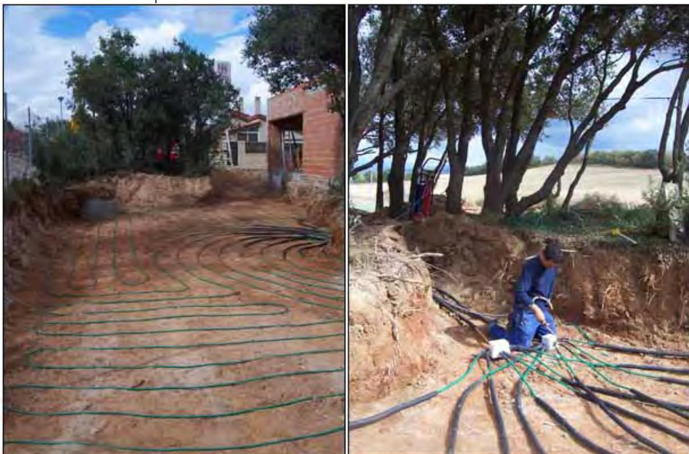
**Foto 4.1. Red de captadores horizontales y unión de tubos. (Fuente: [www.instalacionesalegre.com](http://www.instalacionesalegre.com)).**
