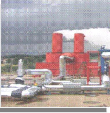
nados más arriba, se inyecta en la turbina en dos fases, al principio y en un punto intermedio, se obtendrá lo que se conoce como una central de doble "flash".
