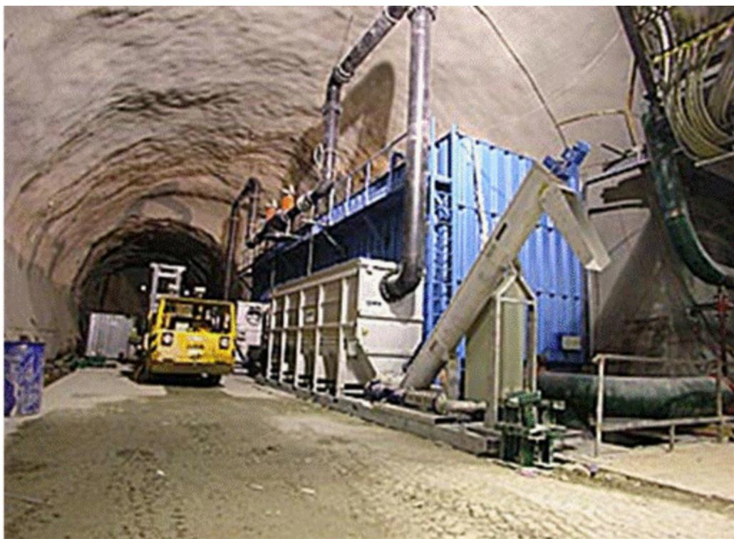
Foto 4.9. Galería con decantador y depósito para el agua subterránea drenada por el túnel de Gothard (Suiza). (Fuente: *Site Geothermie-Perspectives de l'ADEME et du BRGM*).
