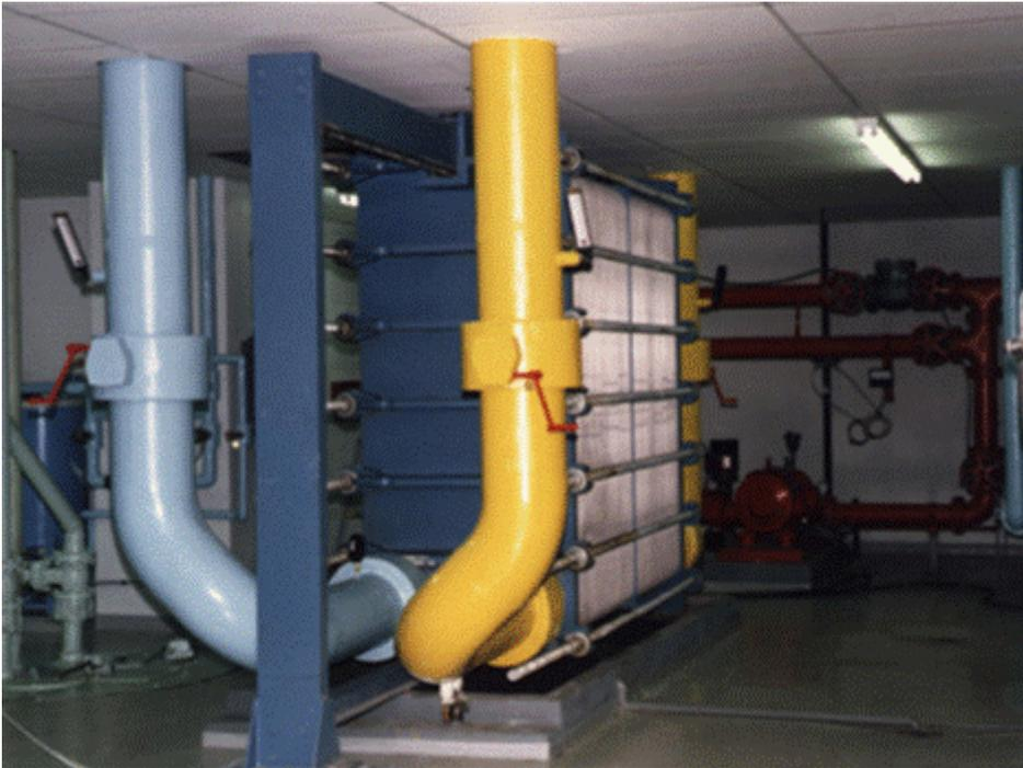
**Foto 5.2. Intercambiador de calor de placas.**
