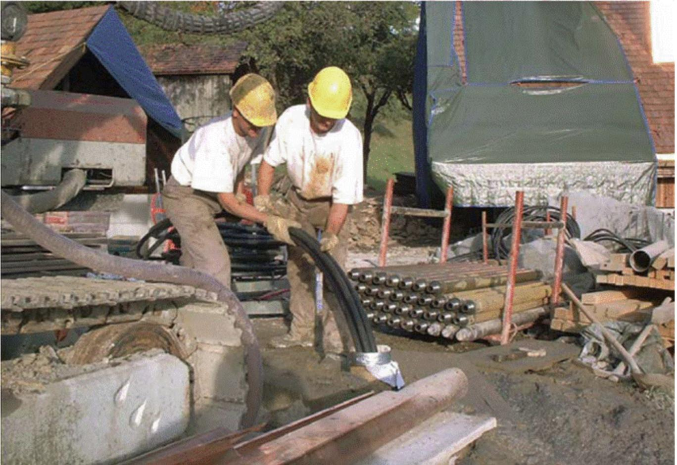
Foto 8.2. Introducción de los intercambiadores en una perforación. (Fuente: *La Géothermie. ADEME - BRGM*).
