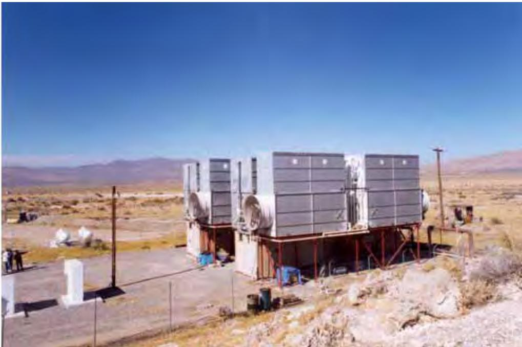
Foto 6.2. Planta eléctrica de ciclo binario en Wendell-Amadee, California. Se aprecia su estructura modular. Su funcionamiento es automático, vigilado por control remoto. (©2000 Geothermal Education Office).
